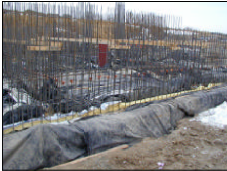
December 2010 Concrete Pour
